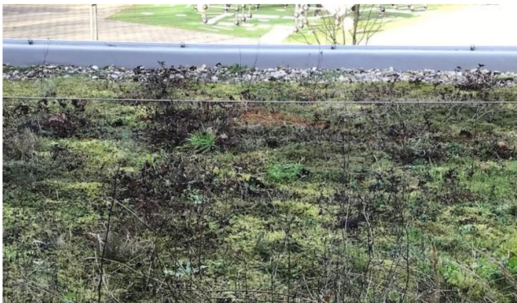
Het sedumdak, voorzien van zekeringslijnen.
