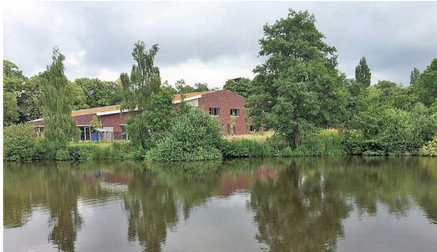
De retentievijver, met op de achtergrond ons schoolgebouw. Links zit de Kinderopvang, aan de rechterkant onze school.
